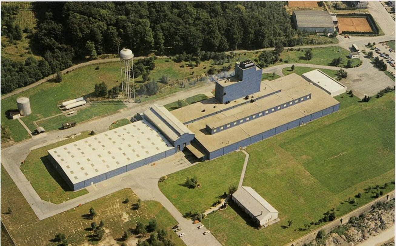
Uniroyal Englebert Textilcord S.A., Steinfort, Luxemburg
