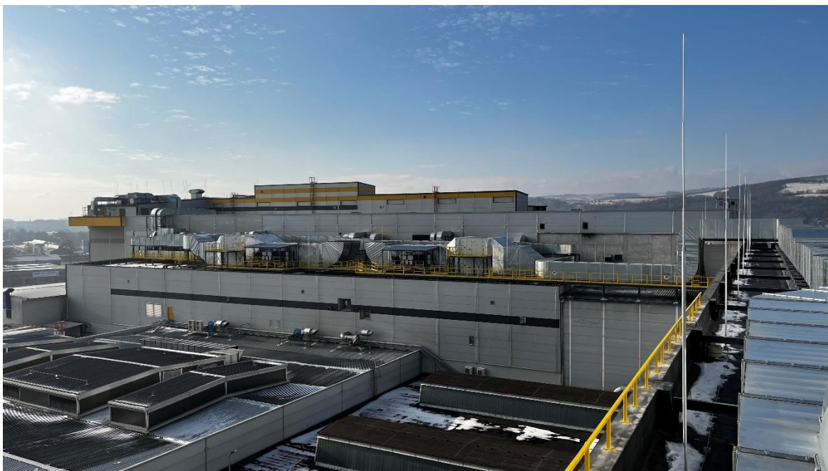
Obrázek 6 – Nové vzduchotechnické potrubí a cold plasma jednotky.
